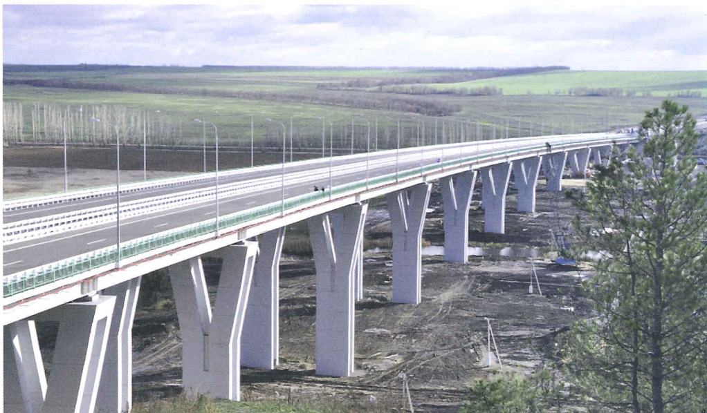
Участок автодороги М-4 «Дон»
